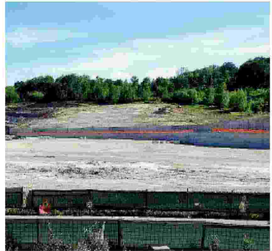
Lavori in corso nell'area del Retail park
